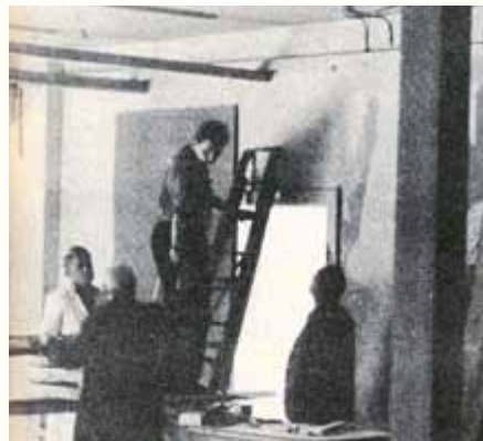
Bei den Umbauarbeiten im neuen Verkaufsstelle Foto: Kreisarchiv Hildburghausen
