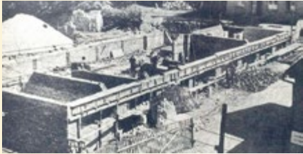
Baufortschritt Anbau Kreiskrankenhaus
