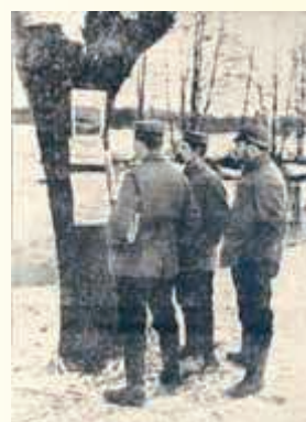
Baum als Anschlagsäule
