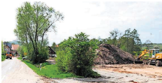
Bei Holzhausen wird derzeit neben der Straße gebaut. Warum man nicht durchfahren kann, ist auf den ersten Blick nicht ersichtlich. Foto: Henning Rosenbusch
