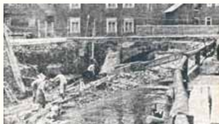
Beim Bau der Brücke über die Schleuse
