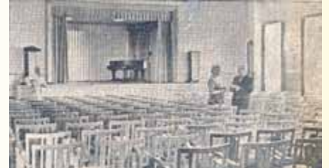
Blick in den Saal kurz vor der Wiedereröffnung
