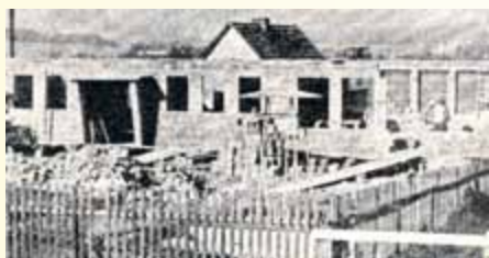
Rohbau des Kindergartens
