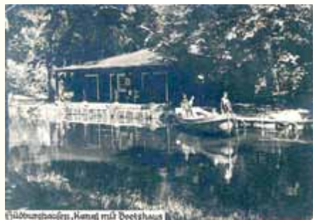
Kanal und Bootshaus
