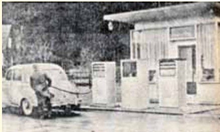
Die neue Tankstelle bei Waldau
