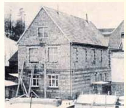
Das künftige Sozialgebäude der Konsum-Gewürzmühle
