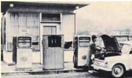
Die neue Tankstelle in Heldburg
