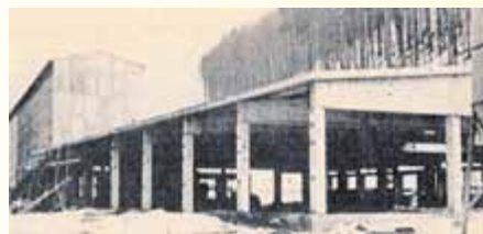
Blick auf die Baustelle vom Sozialgebäude für die Talsperrenbauarbeiter.
